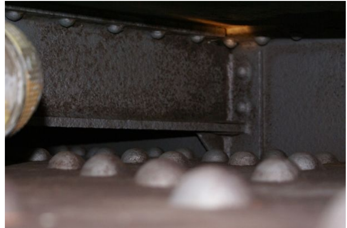
ROZMIAR PRZESTRZENI UNIEMOŻLIWIA WYKONANIE PRAC ANTYKOROZYJNYCH
